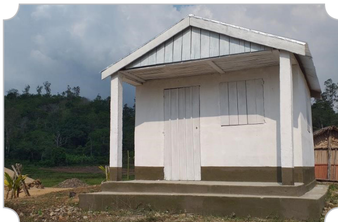
Photo 15 : Poste de garde entretenu à Tsaratanana
