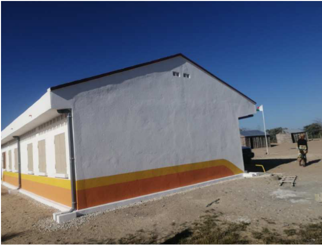
Travaux de construction d'un EPP à BESASAVY NORD
